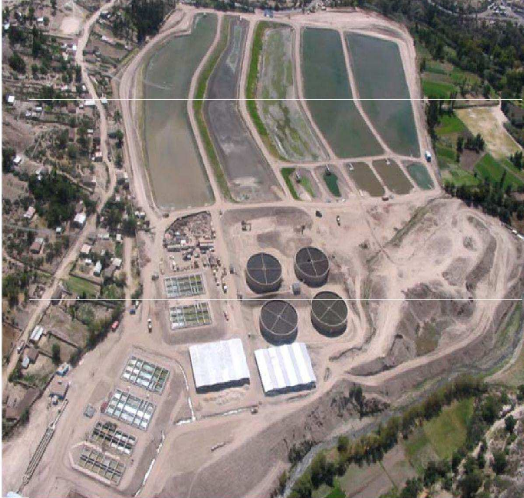
VISTA PANORAMICA PTAR TOTORA
