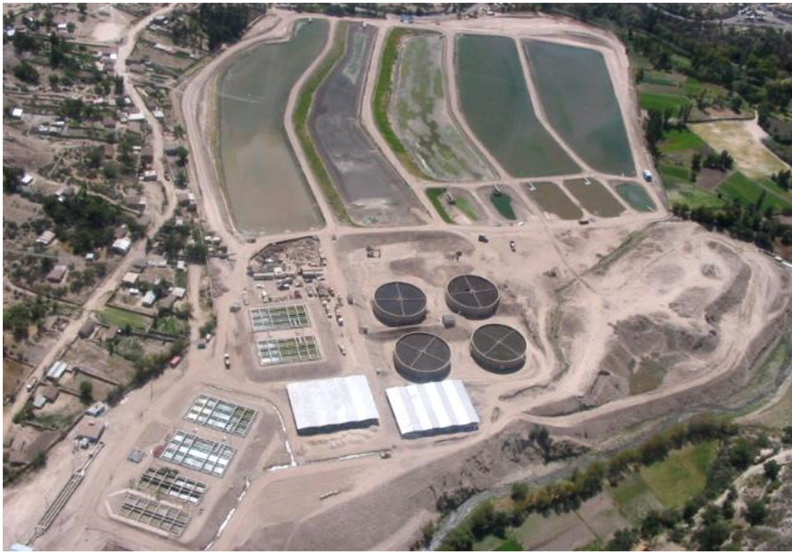
VISTA PANORAMICA PTAR TOTORA
