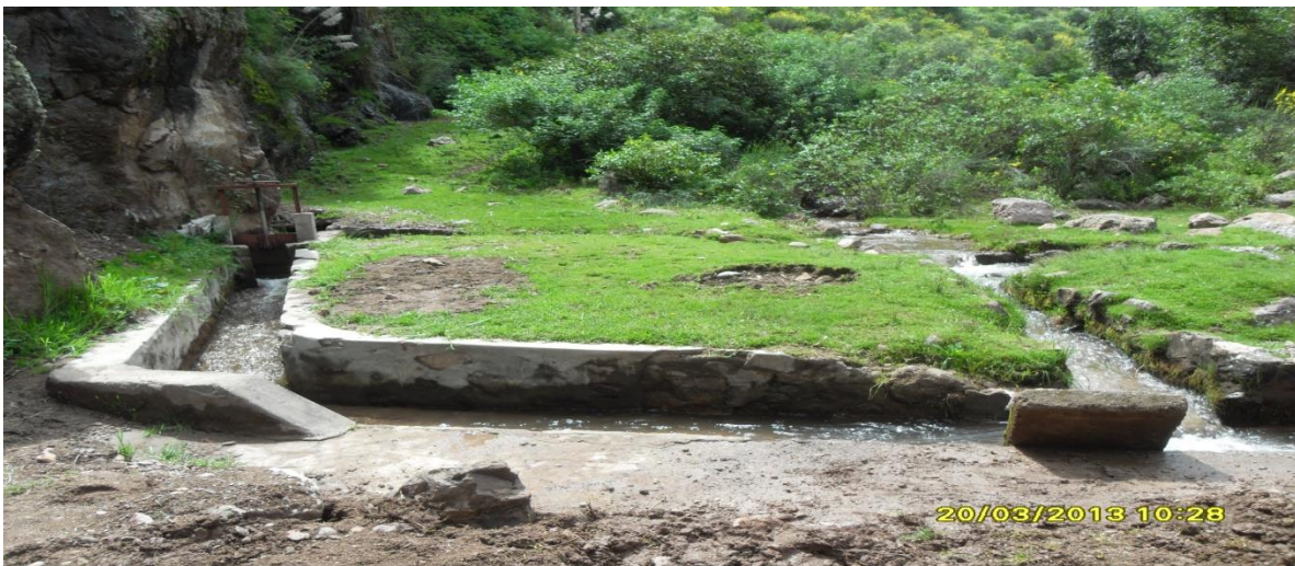
Fuente: Captación del agua cruda en el ríoHuanta.
