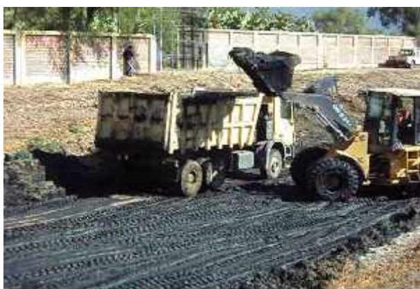
Labores de Descolmatación de la laguna primaria N°01 de la PTAR ICHPICO.
