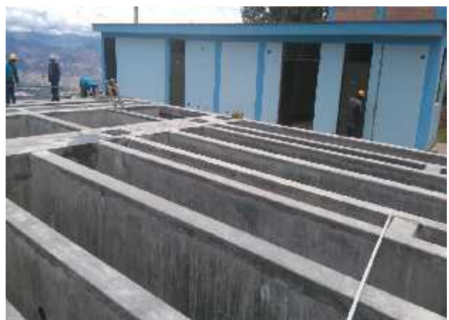
Planta de tratamiento de agua potable - Huancayocc
