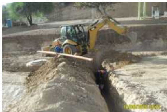
Trabajos de instalación de desagüe.
