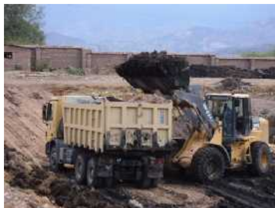
Labores de Descolmatación de la laguna primaria N°01 de la PTAR ICHPICO.
