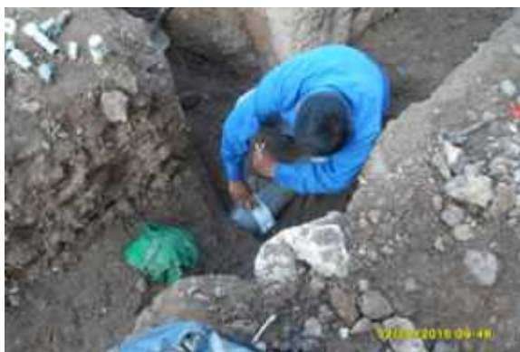
Trabajos de instalación de agua potable
