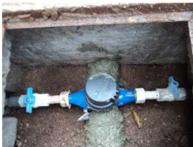
Micromedidor instalado con anclaje de concreto.
