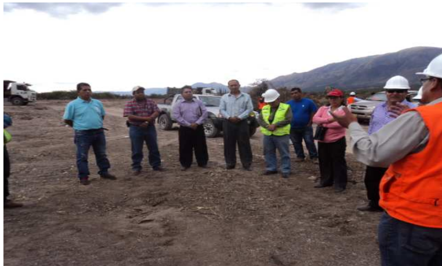
Fotos: SNIP 9999; Construcción de las lagunas de tratamiento de aguas residuales en PUCA PUCA- Pampachacra( avance nivelación del terreno).presencia del alcalde saliente y el electo, empresa ejecutora y supervisión y presencia del responsable del Ministerio de Vivienda Ing a Peña.
