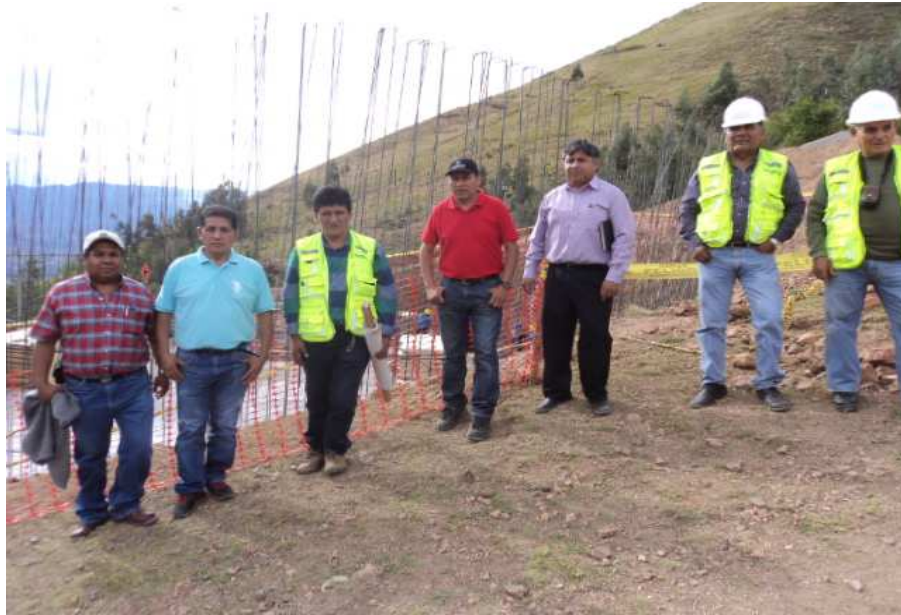
Fotos: SNIP 9999; Construcción del reservorio y la nueva planta de tratamiento de agua potable en Huancayocc. (Avance cerco perimétrico construido, cimentación de la base del reservorio, cimentación de las oficinas y de la planta).
