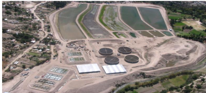
Foto 30 Vista panorámica de la PTAR Totorá
