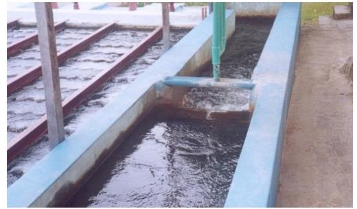
Foto 10 Unidad de mezcla rápida Fuente. Registro EPSASA.
