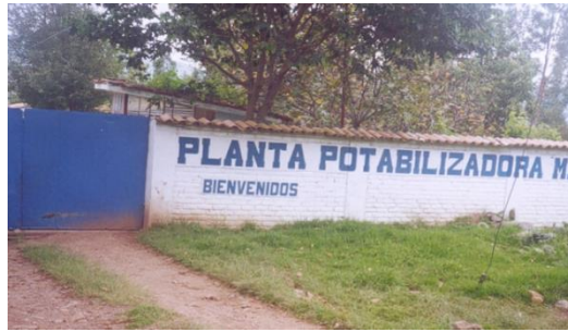
Foto 9 Vista Fachada de PTAP Matará Fuente. Registro EPSASA.
