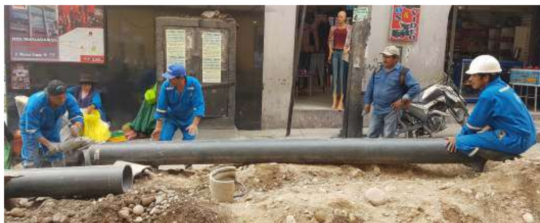
Reparación de tubería matriz
