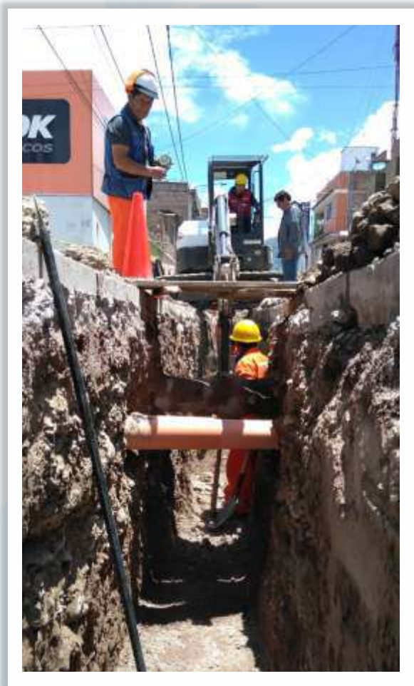
Fotos obra Línea de Conducción Acuchimay a Jr. Quinua
