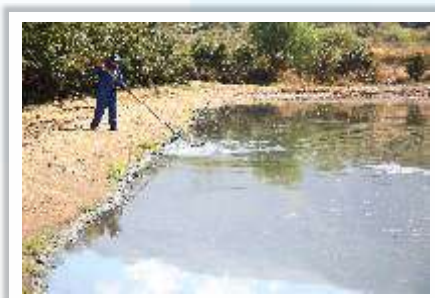
Planta de Tratamiento de Aguas Residuales ICHPICO
