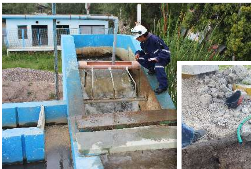
Cámara de mezcla rápida PTAP #1
