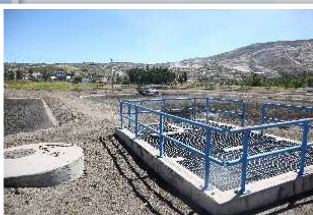
Instalaciones de la Planta de Totorá
