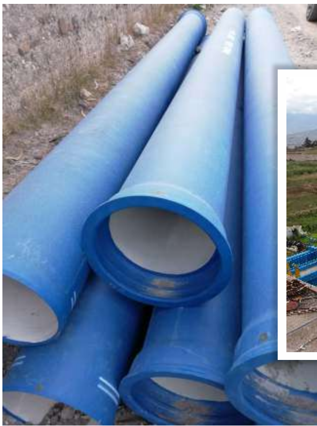
Tubería línea de conducción
