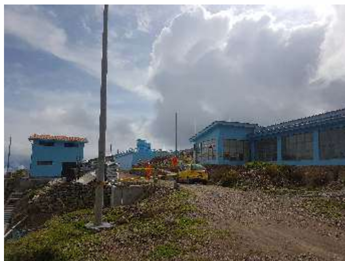
Planta de tratamiento de Agua Potable Cabrapata
