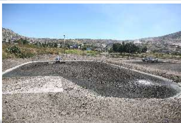
Laguna de Maduración
