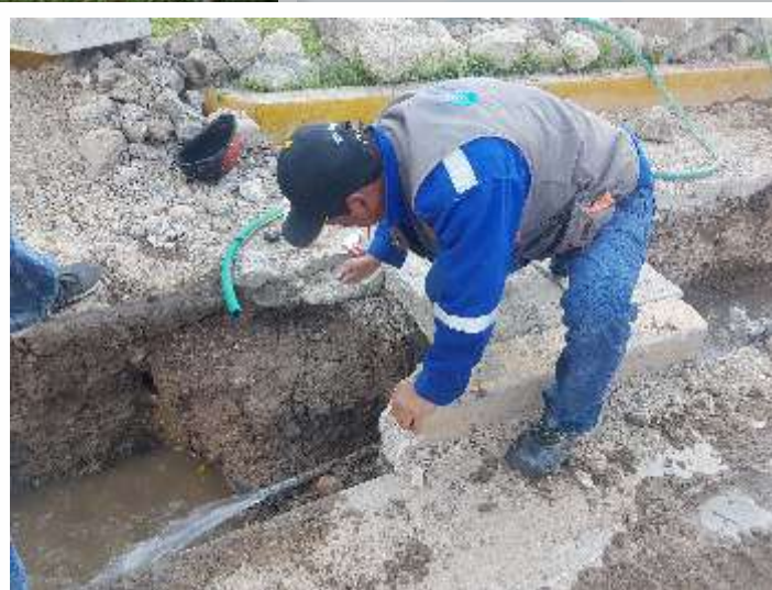
Detección de Instalaciones Clandestinas
