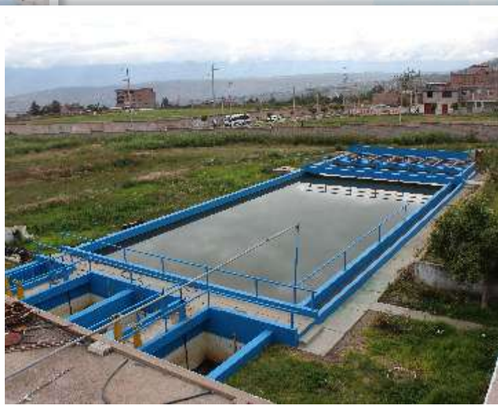
Planta de tratamiento de Agua Potable #2
