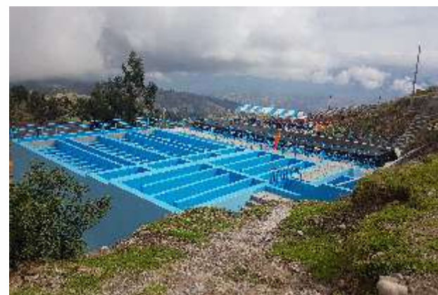
Vista Planta de Tratamiento de Cabrapata
