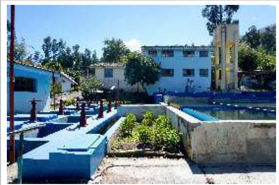
Filtros Planta de Tratamiento Matará
