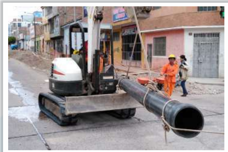
Cambio tubería línea de conducción Acuchimay a Jr. Quinua
