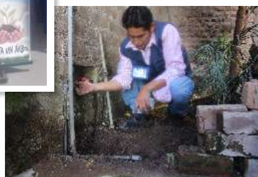
Reparación de instalaciones intradomiciliarias
