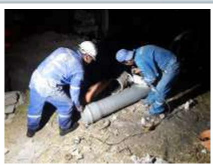
Reparación de tubería matriz
