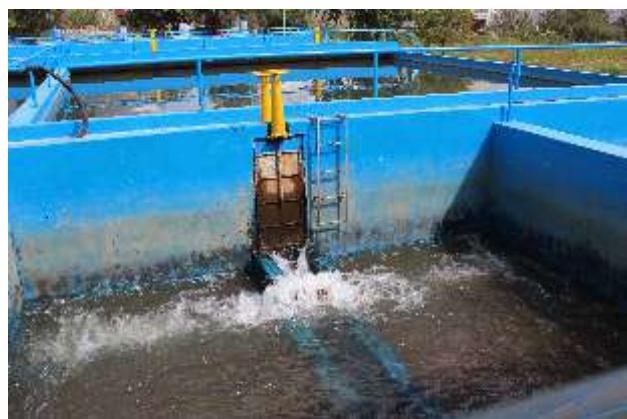
Filtros de la PTAP de Quicapata
