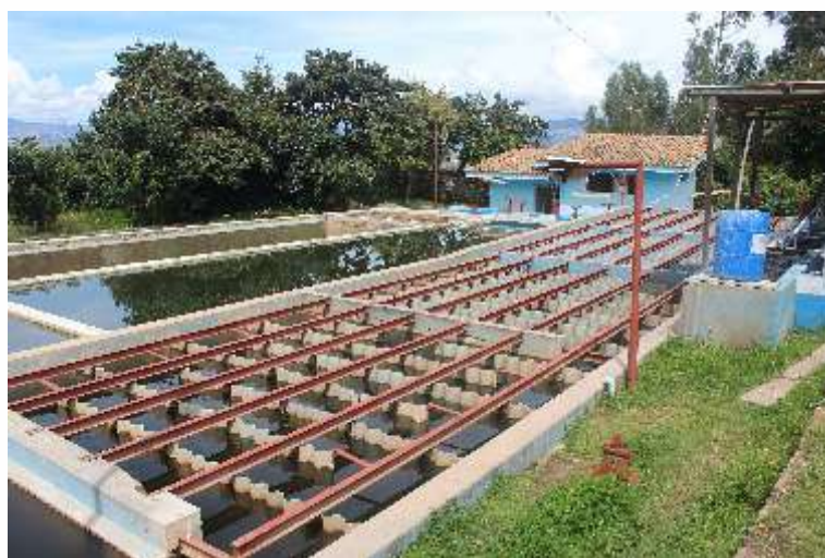
Planta de Tratamiento de Agua Potable Matará
